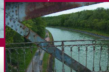
Canal depuis le pont
